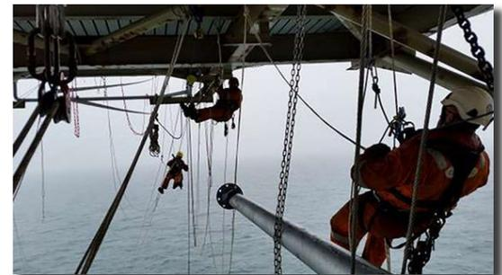
Montaje de tubería en voladero (sin andamios)
